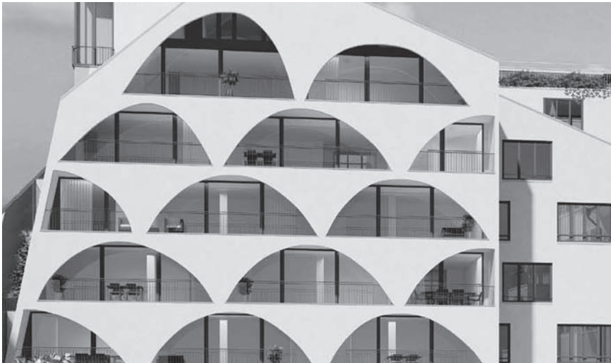
Yachthafen Lindau – Projekt der Firma Rhomberg Bau (Abdruck mit freundlicher Genehmigung der Firma Rhomberg Bau)
